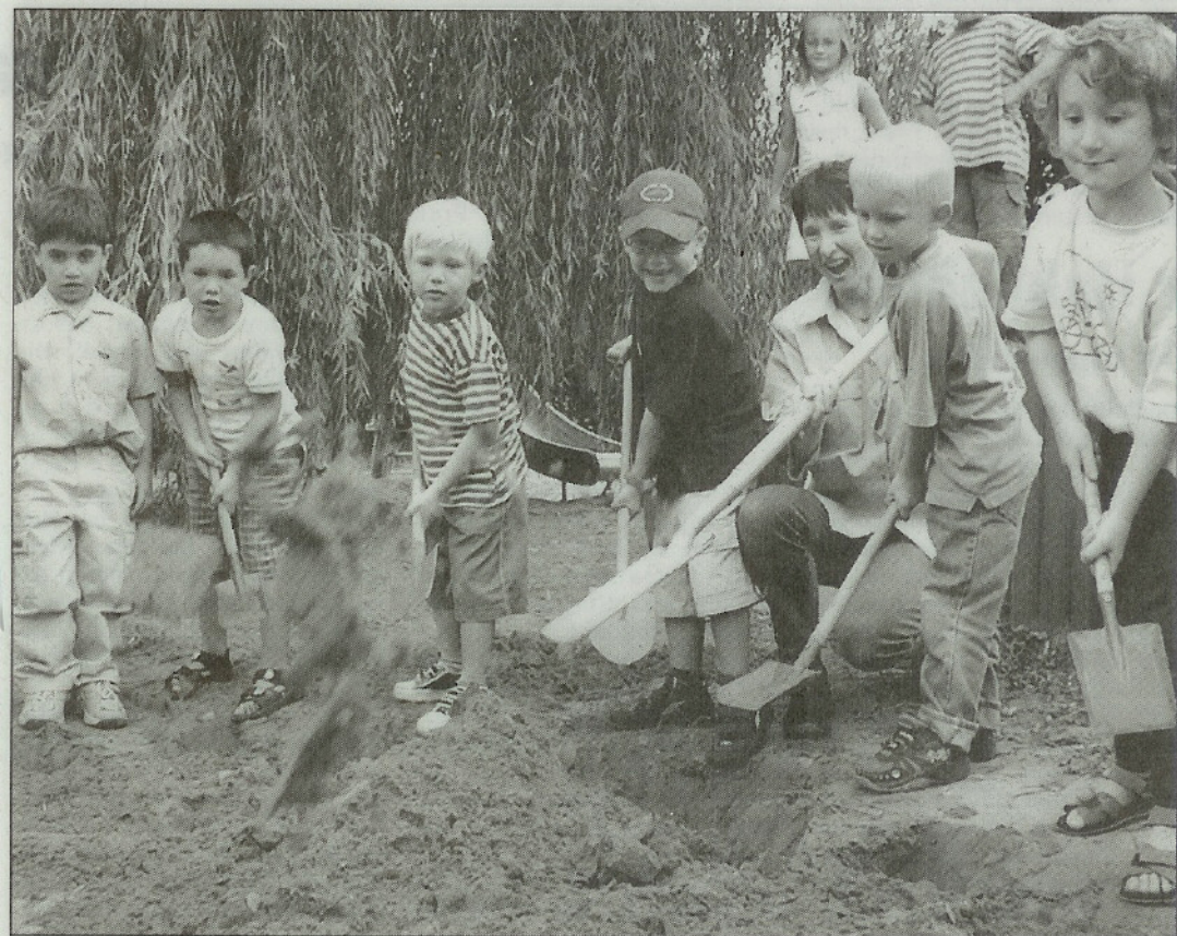
KRÄFTIG ZUGELANGT haben Mädchen und Jungen mit Hortleiterin Ilona Schmitt von der evangelischen Kindertagesstätte in Eschollbrücken beim ersten Spatenstich für die Erweiterung und Neugestaltung der Außenanlage. Zum Bericht. (Foto: lip)
